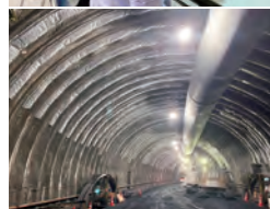
都市計画道路 原松原線バイパス整備事業 トンネル工事現場視察
